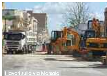
I lavori sulla via Marsala
